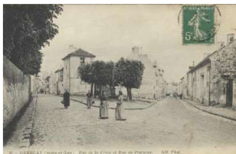
Rue de la Croix et rue de Pontoise
