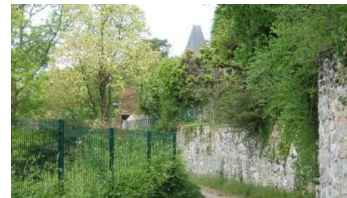
Le mur d'enceinte médiéval
